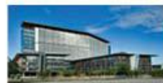
Menara PjH, Putrajaya
